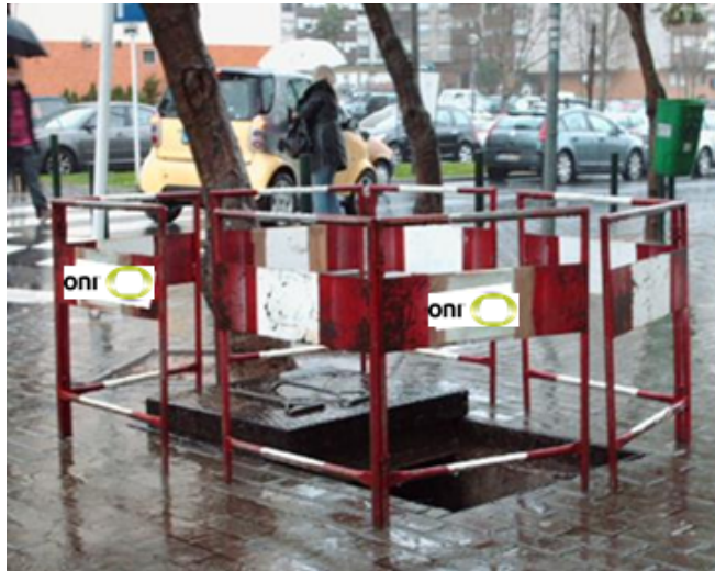
Imagem 1. Exemplo de Sinalização da entrada na Câmara de Visita
